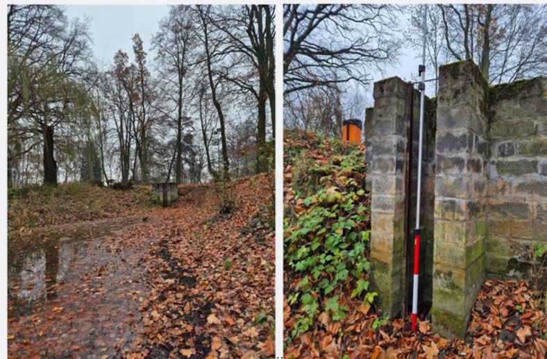
Fot. 6.4.2.3. Mnich na połączeniu zbiorników na działce 25/9, obręb Kołuda Wielka. Nieczynna, do odbudowy – dno zastawki = 79,829 m n.p.m. (52°44'03.8419"N 18°09'14.8404"E).
